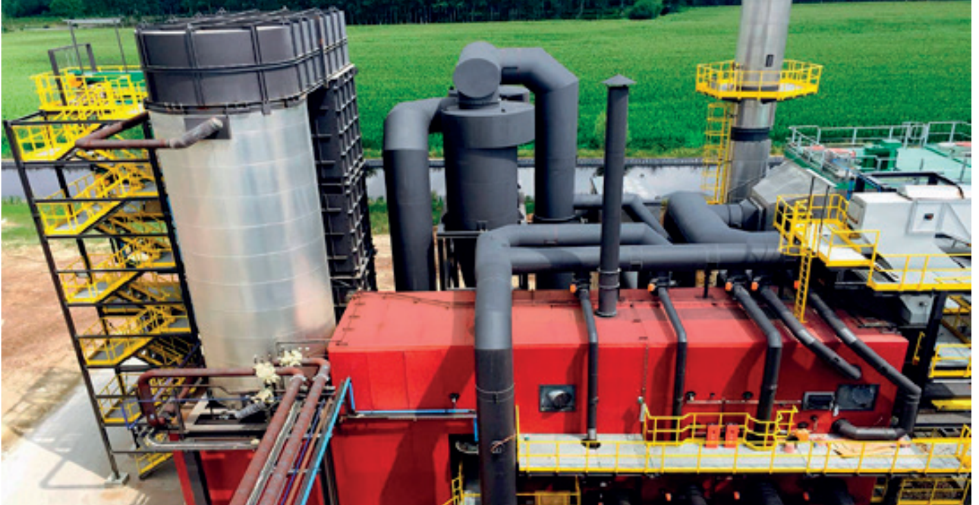
Chaudière combustion de biomasse avec chambre postcombustion horizontale - 12 MW - France
